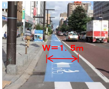
【ブルーレーンの設置状況】
