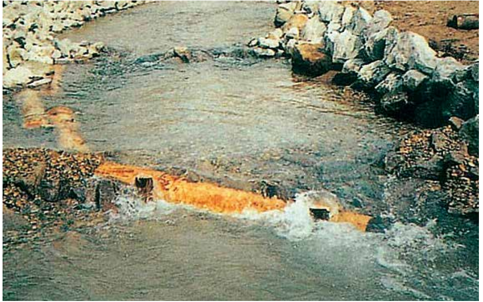
写真6 丸太水制工を設置した排水路 写真中央と左に設置した丸太で流れの変化をつくっている
