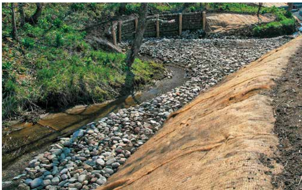
写真5 現況の河道線形を保全し、片岸のみを整備した排水路
