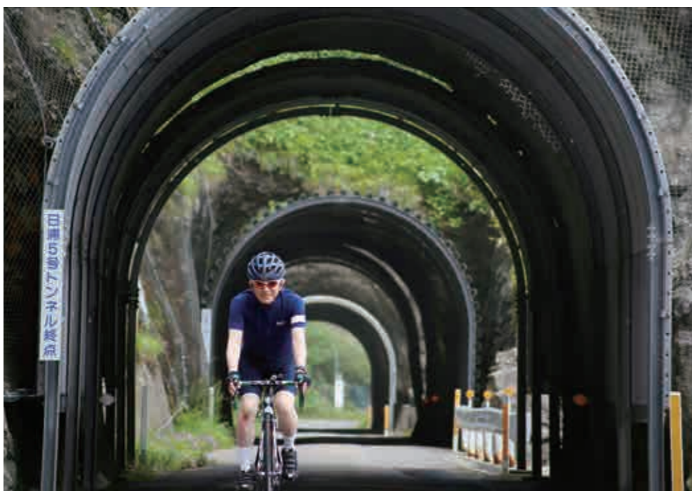
素掘りしたトンネルが7つ連続する「日浦洞門」は道南土木遺産に指定されている。
