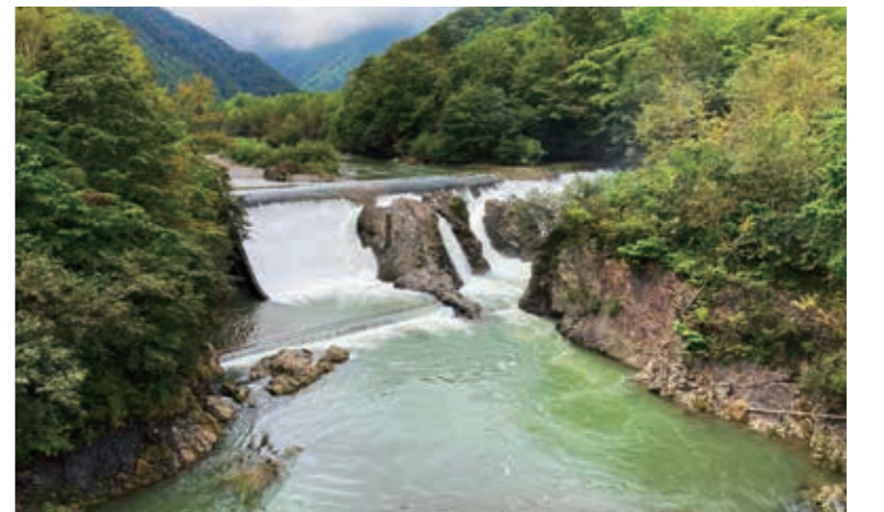
写真11 土砂で埋没したダムが滝となり「ピョウタンの滝」と名付けられた。札内川の清流を集めて10メートルの落差で流れ落ちるさまは観光客にも人気のスポットになっている。
