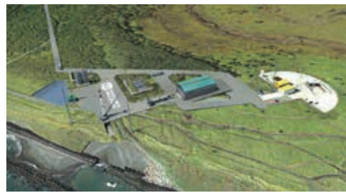
写真1 垂直打ち上げロケット用の発射台や組立棟、推進剤などのタンクヤードを常設するLaunch Complex-1(LC-1)。
