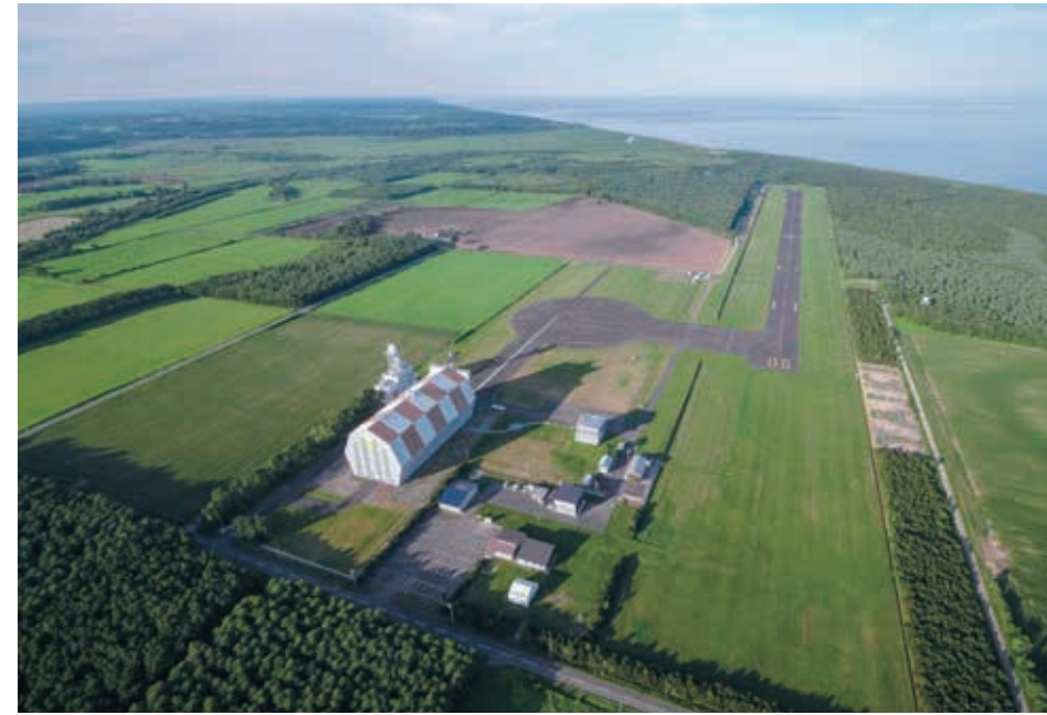
JAXAの格納庫と既存の1,000m滑走路(現在1,300mに延伸工事中)の全景。今後も垂直打ち上げロケットや水平離発着のスペースプレーンの実験・打ち上げまで、さまざまな顧客のニーズに応える各種設備を揃えていく。
