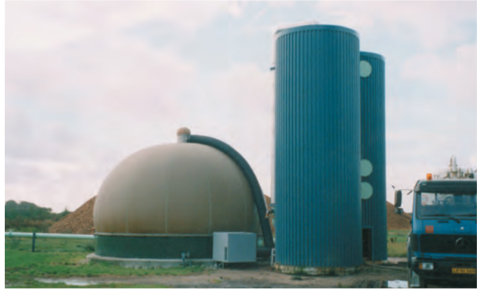
脱硫設備及びガスホルダーの例
