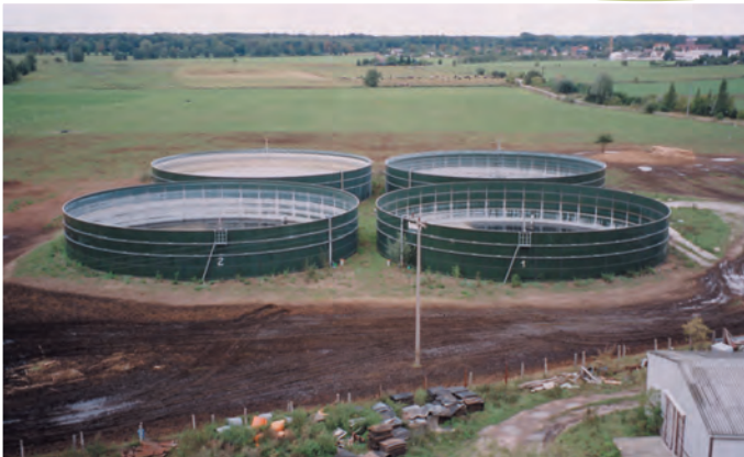
消化液貯留設備の例
