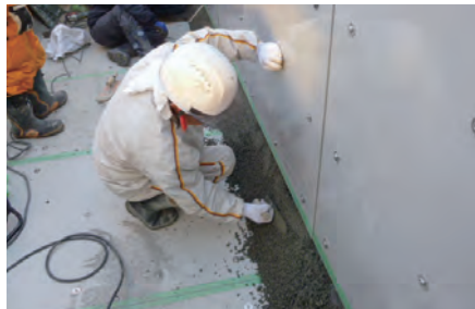
④FRPM板設置(側壁)
