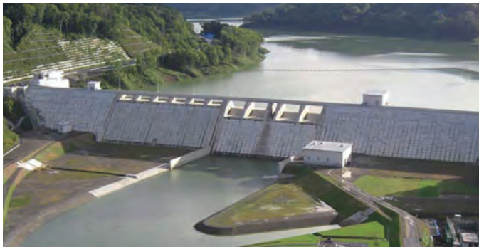
●台形CSGダム型式で建設された当別ダム(北海道)
