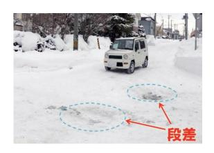
下水道マンホールの上の積雪は、下水の熱によってその部分だけ雪が融け、その結果、道路に段差が生じます。 段差が大きくなると交通上の支障となるほか、歩行者の転倒や自動車の破損などを引き起こす可能性があります。
