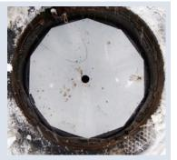
試作品断熱マンホール蓋 二重蓋型(厚手) 勾配受\*設置型
