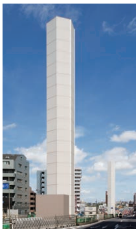
上落合換気塔
