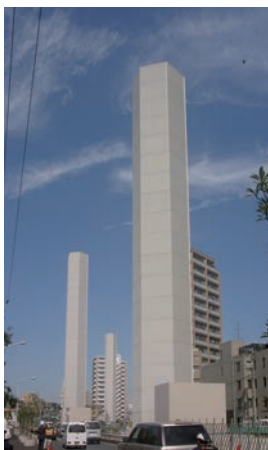
神山町換気塔
